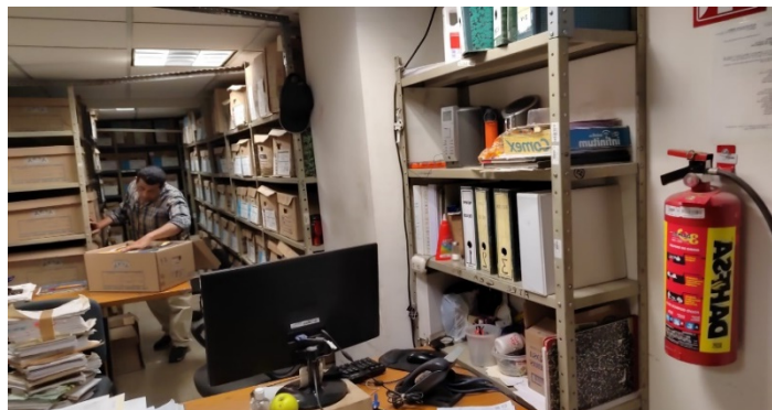
Imagen 9: Evidencia fotográfica de extintores y señalética de evacuación.
