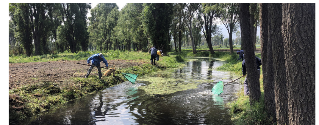
Limpieza de canales
