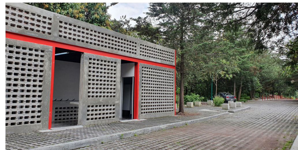
Módulo de baños
