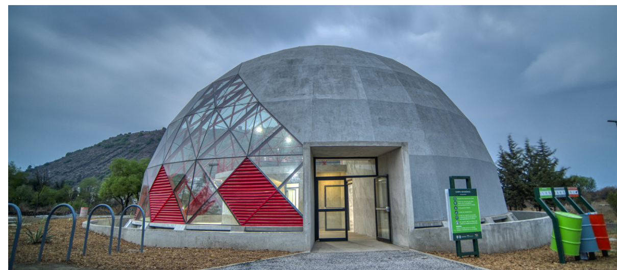
Carpa Geodesica entrada
