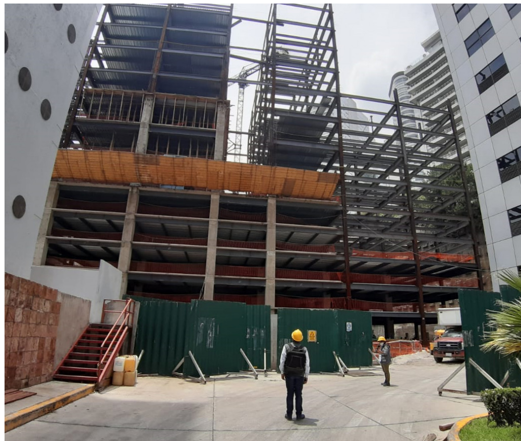
Inspección en obras
